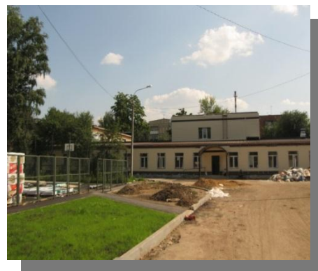
Здание детского сада № 7 (в стадии ремонта)
